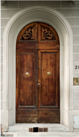
Portone odierno d'ingresso all'edificio in via Manzoni 21
