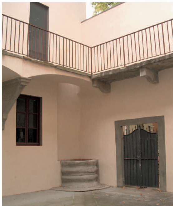
Corte interna, con pozzetto, di Casa Lapi
