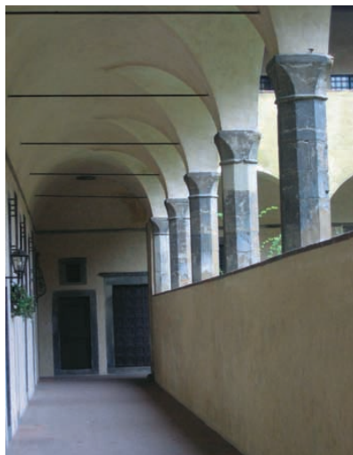
San Lorenzo, Chiostro minore su cui si affaccia l'entrata dell'archivio.
