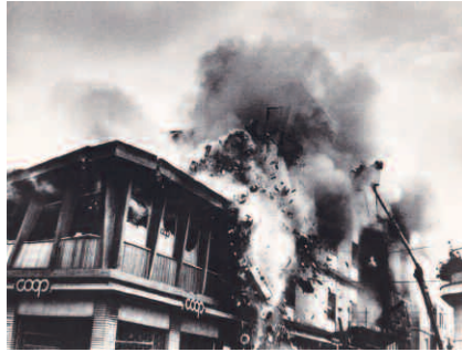
Unicoop Tirreno, Atti diversi del Consiglio di amministrazione , carteggio relativo all'incendio del negozio di via Gori, Piombino, 1972
